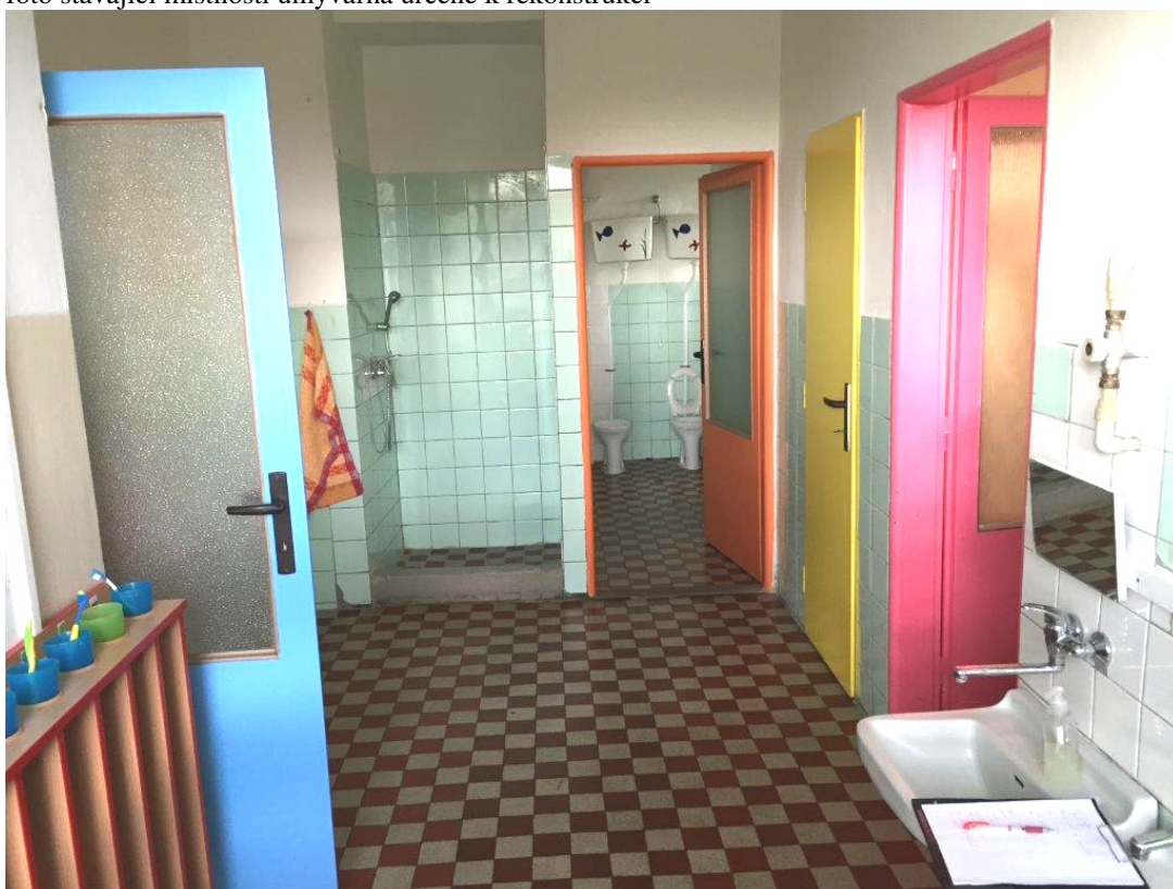
foto stávající místnosti s umývárna určené k rekonstrukci
