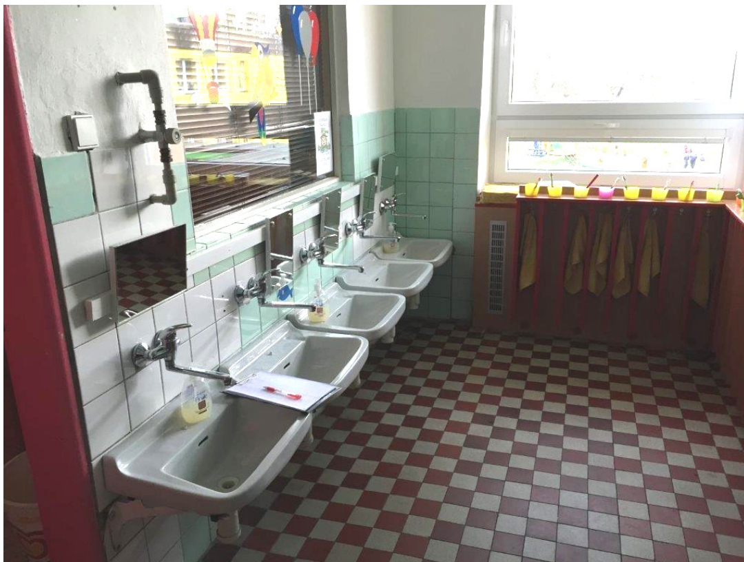
foto stávající místnosti umývárna určené k rekonstrukci
