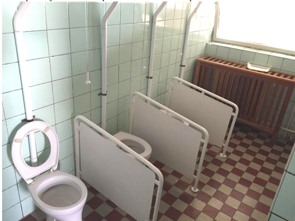
foto stávající místnosti s WC určené k rekonstrukci
