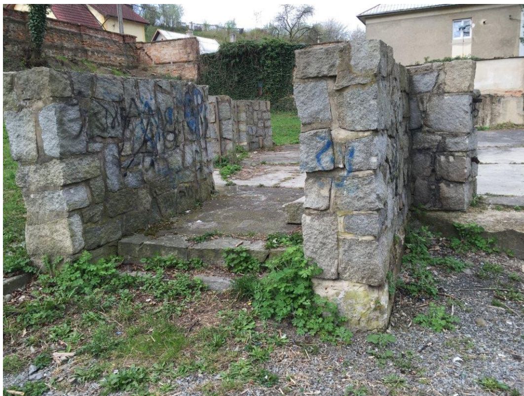
stávající boční schodiště
