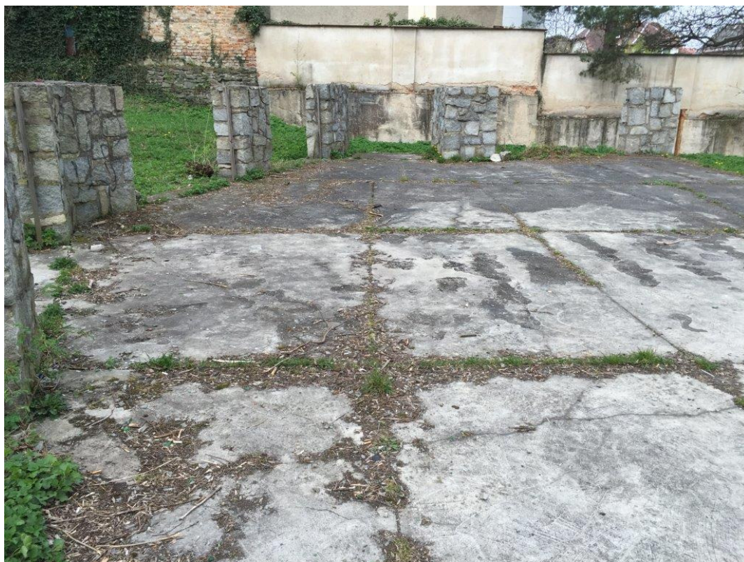
stávající podlaha a zídky z kamene určené k demolici
