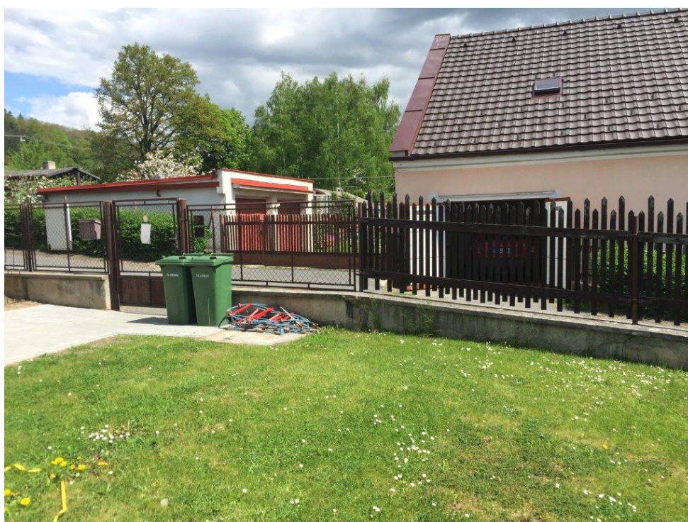
vlevo - trasa 3- 19mb stáv. ocelové rámové oplocení na ocelových sloupcích
