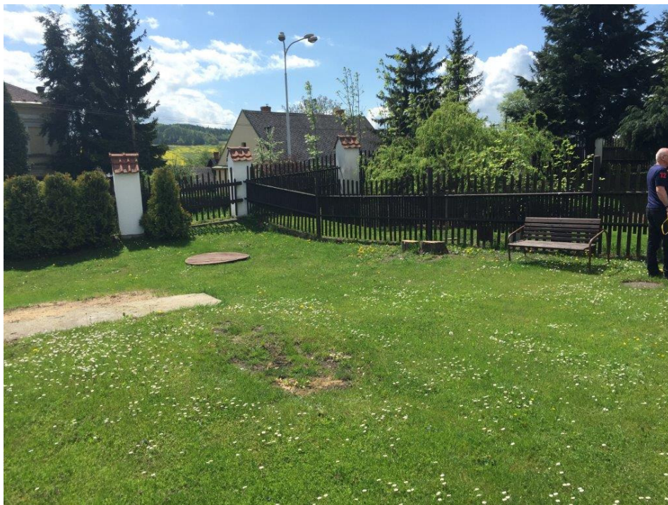
vpravo - trasa 1- 35,5mb stávajícího dřevěného latkového oplocení na ocelových sloupcích vlevo - trasa 2- 12,5mb stáv. dřevěné tačkové oplocení na zděných sloupcích
