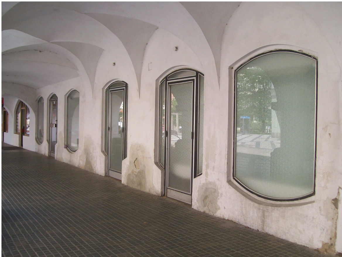
Pohled čelní - část Zámecké nám. 15/3, Krnov
