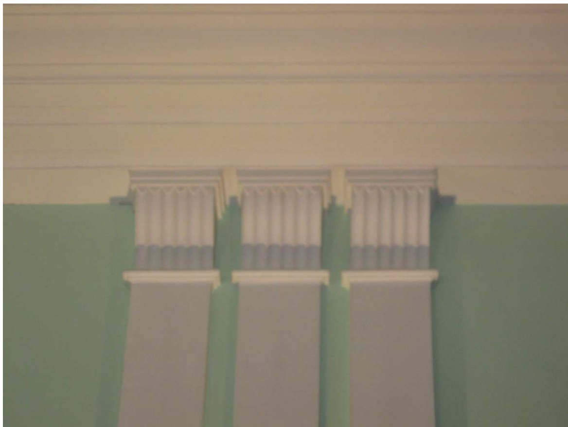
Foto č.5 – Detail hlavice sdružených pilastrů
