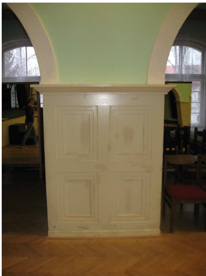
Foto č.6 – Detail kazetového obložení sloupů
