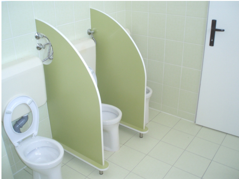
vzor svislé přepážky mezi jednotlivými WC
