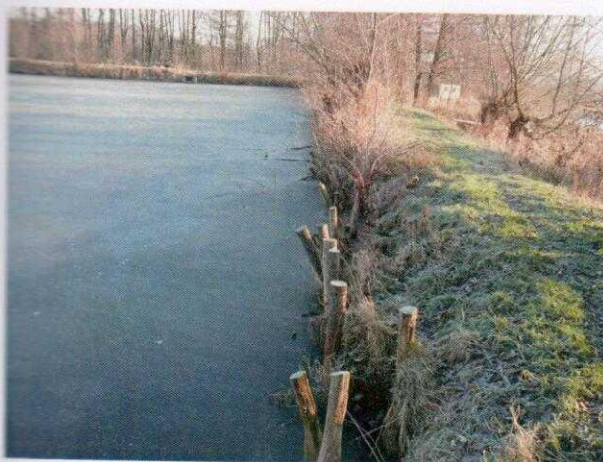
boční hráž s rozpadlým opevněním
