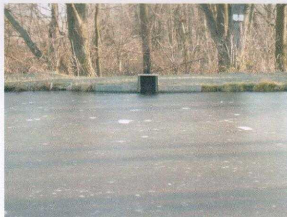
opevnění betonovými křídly
