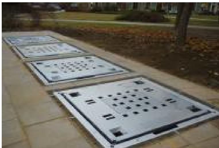
obr. č.2 Realizované podzemní kontejnery v Krnově Bezpečnostní protipodlaha, vyjede při vyzdvížení kontejneru, aby bylo zabráněno pádu do jímky.
