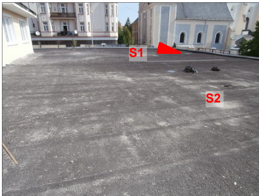
obr /4/ Pohled část předmětné střechy
