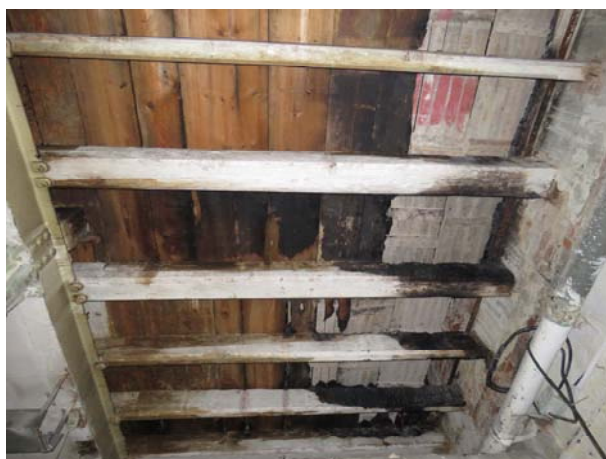
Obnažené a poškozené stropní trámy nad 1.NP – po vybourání betonové desky – rozepření spodní příruby zajištěno ocelovými profily navařenými v sousedním poli na spodní hranu I 400
