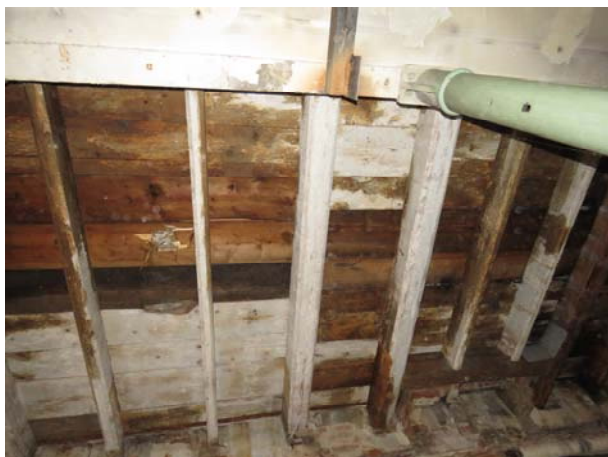
Chybějící podlaha stropu nad 1.NP
