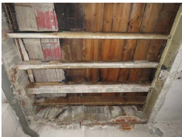
Chybějící podlaha stropu nad 1.NP
