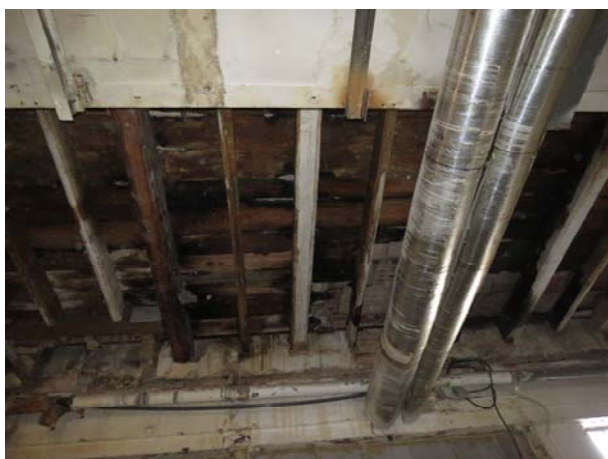
Obnažené a poškozené stropní trámy nad 1.NP – po vybourání betonové desky – rozepření spodní příruby zajištěno ocelovými profily navařenými v sousedním poli na spodní hranu I 400
