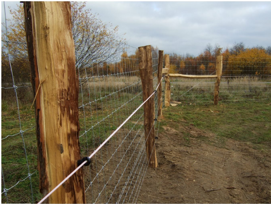
aklimatizační ohrada - ohrazení z el. ohradníku s uzlíkovým pletivem na štípaných akátových kůlech
