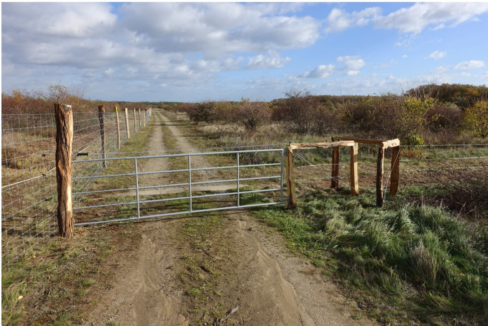
detail pastevní brány s průchodem pro pěší (šipka, zpevňovací hrazdy)
