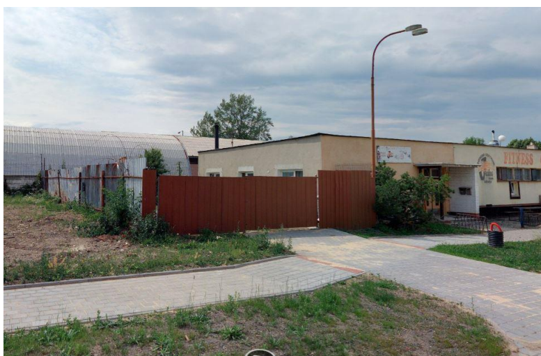
SO02 oplocení bývalé fitness centrum JALEX
