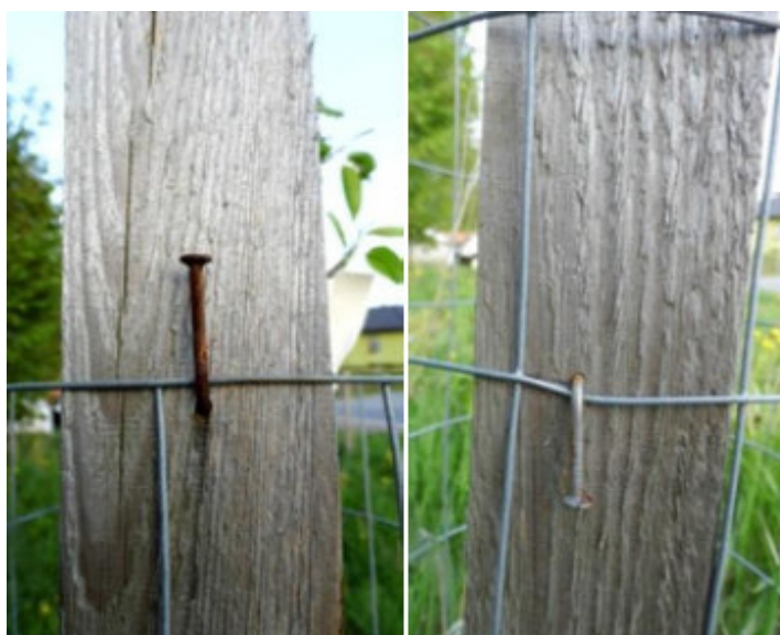
Obrázek 5 Připevnění pletiva hřebíky
