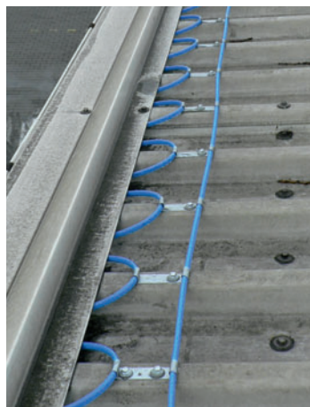
instalace topného kabelu na atypickém okraji střechy
