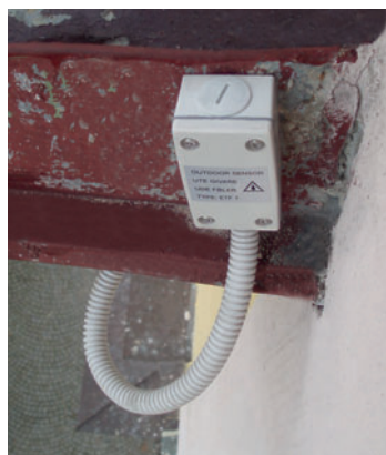
ukázky instalace teplotního čidla ETF
