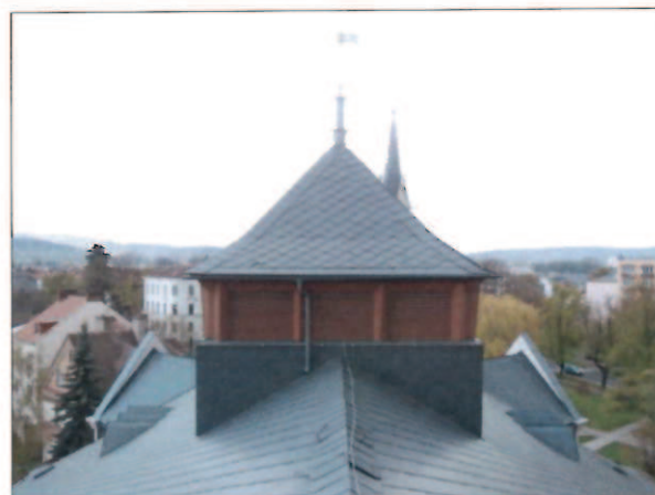
obr /5/ Pohled na věžičku objektu
