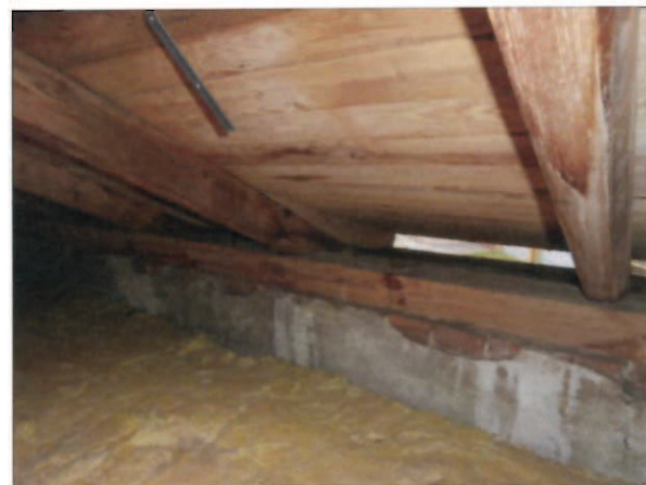
obr /31/ Pohled na příváděcí otvory u okapu střechy
