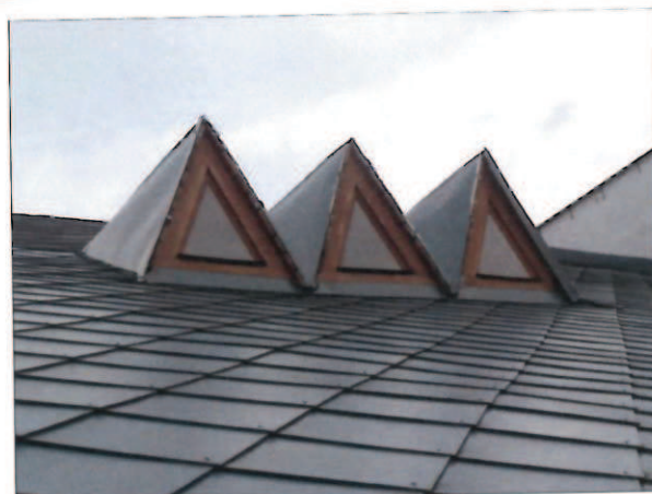
obr /19/ Pohled na střešní vikýře – poškozené čelní lemování
