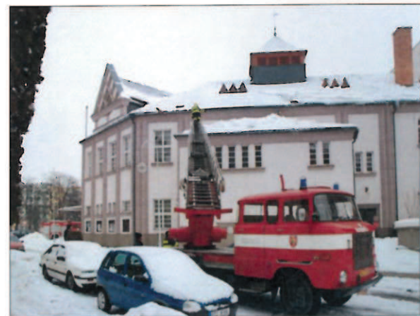
obr /35/ Pohled na objekt v době zásahu při odklizení sněhu [12]
