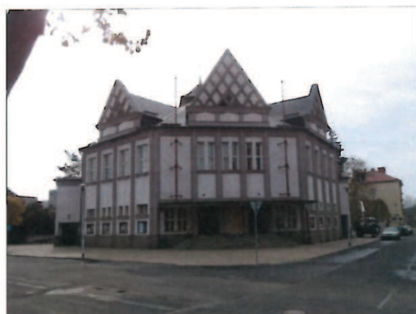
obr /3/ Pohled na severozápadní část objektu
