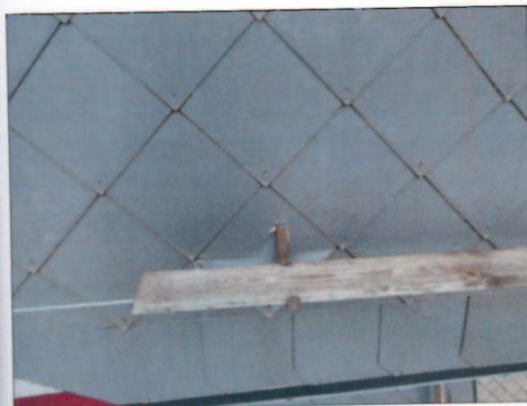
obr /22/ Pohled na kotvení sněhového zachytávače
