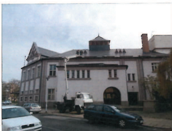
obr /2/ Pohled na jihozápadní část objektu
