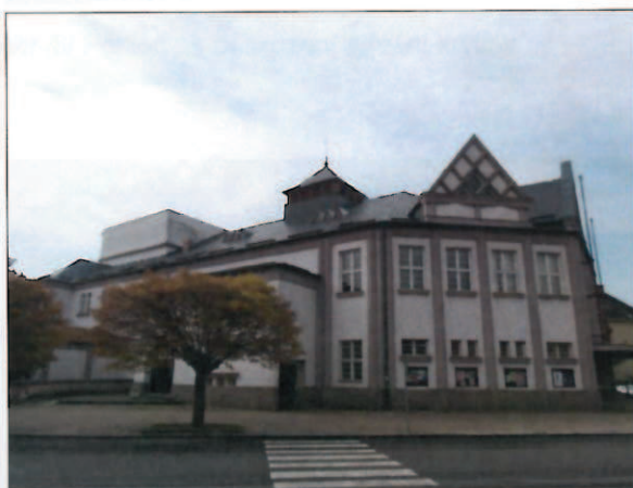
obr /4/ Pohled na severovýchodní část objektu
