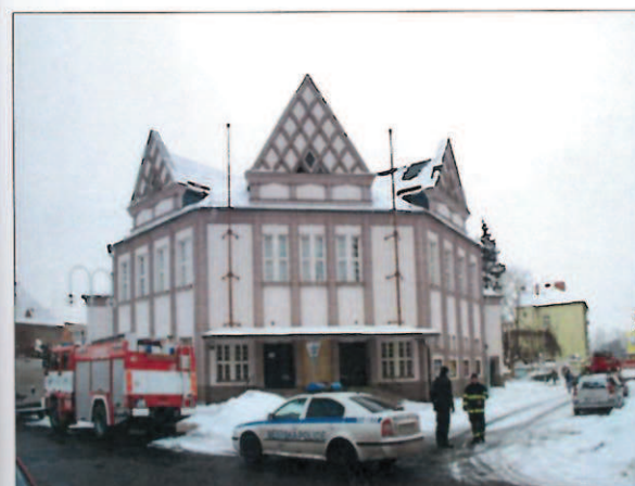
obr /34/ Pohled na objekt v době zásahu při odklizení sněhu [12]
