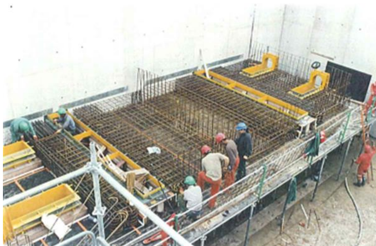
Obr. 7 Armování kalového bunkru o objemu cca 100 m 3 se dvěma čerpadly ve dně a 4 hydraulickými písty pro shrabování
