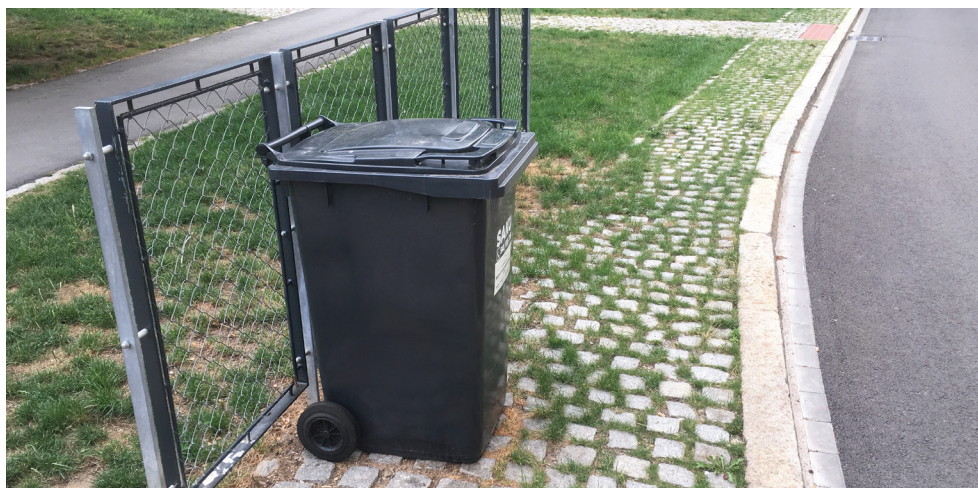
Příklad vedlejší dlážděné plochy z žulových odseků
