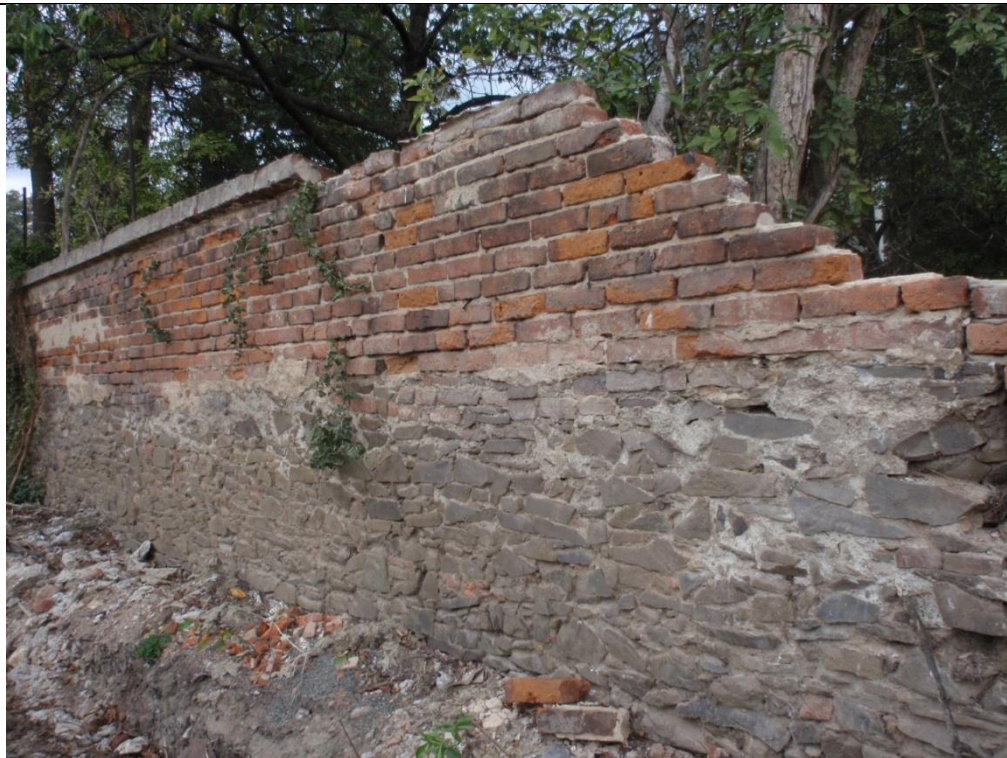
SO03.12 ZEĎ Z POHED. CIHEL S KAMEN. PODEZDÍVKOU – STÁVAJÍCÍ STAV
