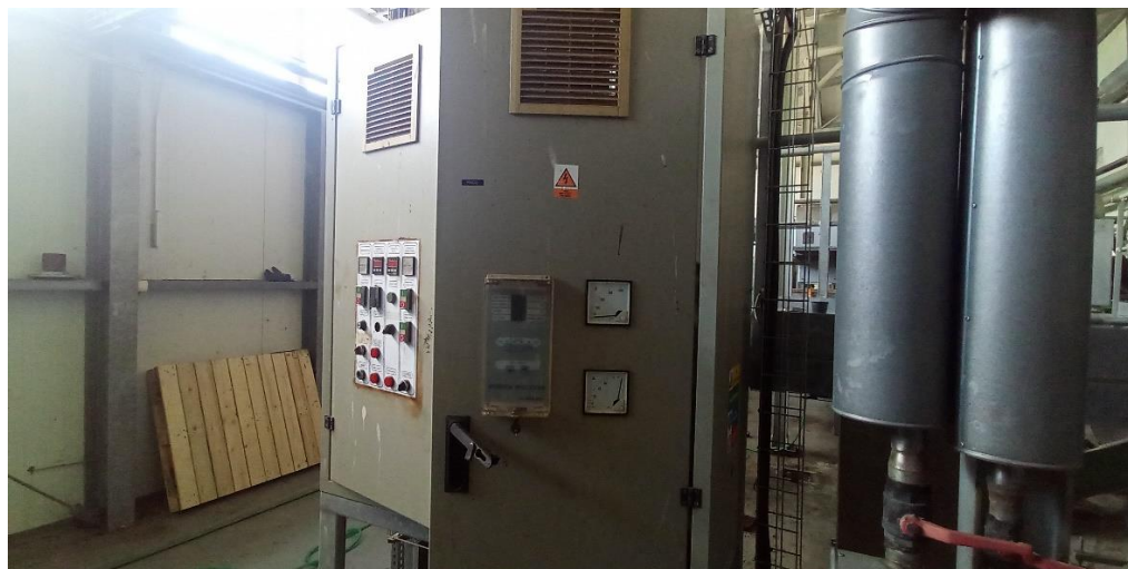
Obr. 10: Stávající rozvaděč pro odstředivku č. 1
