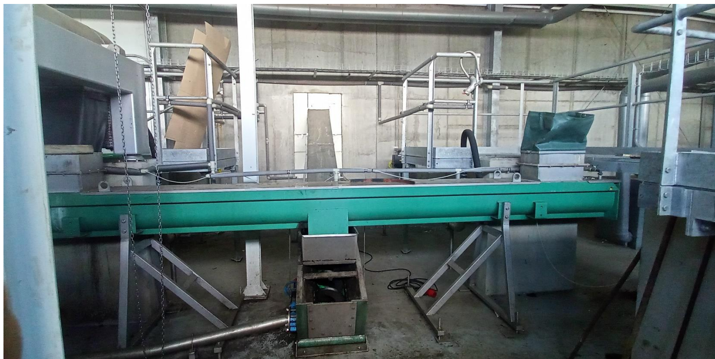
Obr. 17: Stávající šnekové dopravníky kalu na výstupu z odstředivek, vlevo z č.2, vpravo z č.1
