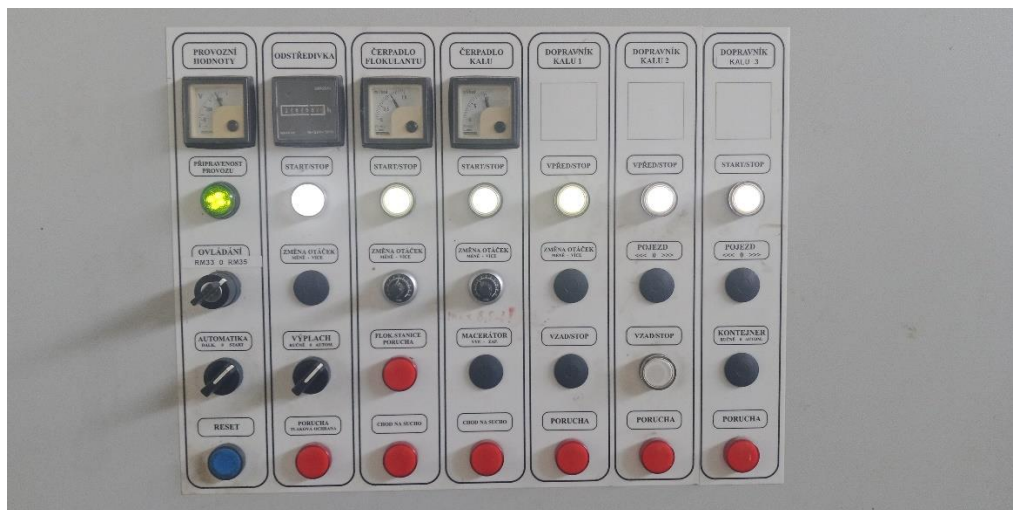
Obr. 9: Stávající rozvaděč pro odstředivku č. 2
