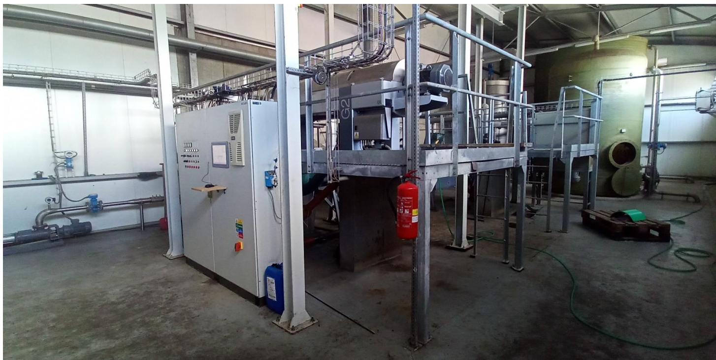
Obr. 15: V popředí stávající odstředivka č. 2 a technologický rozvaděč č. 2
