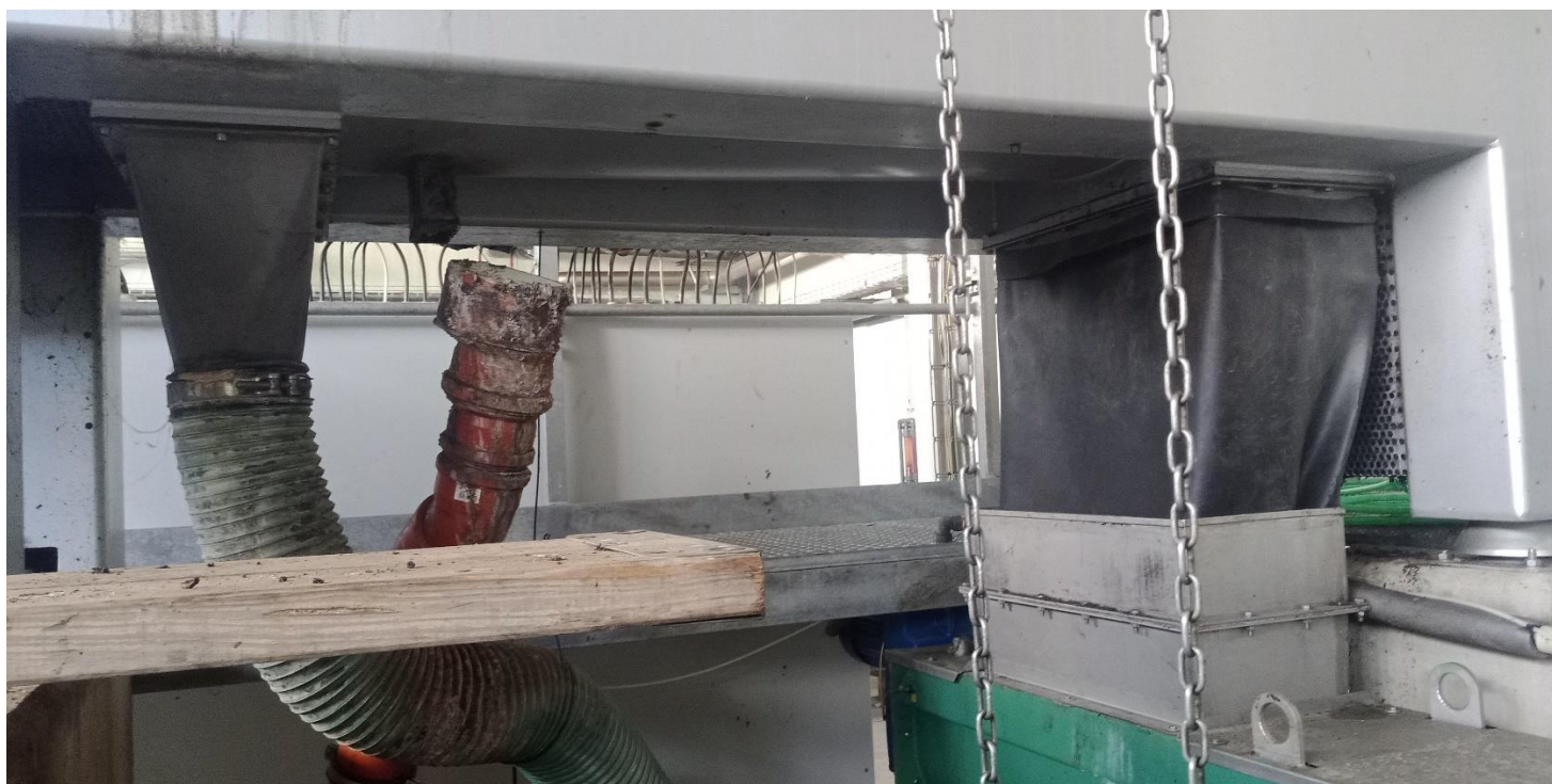
Obr. 16: Stávající výsypky kalu a fugátu z odstředivky č. 2
