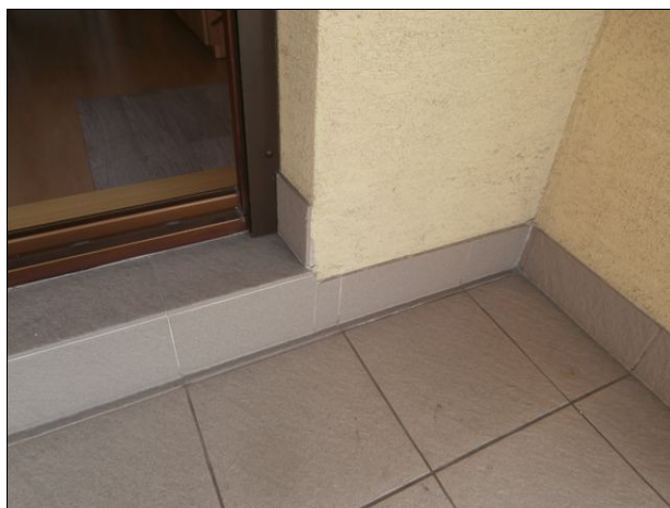
obr. /5/ Pohled na ukončení dlažby u dveří
