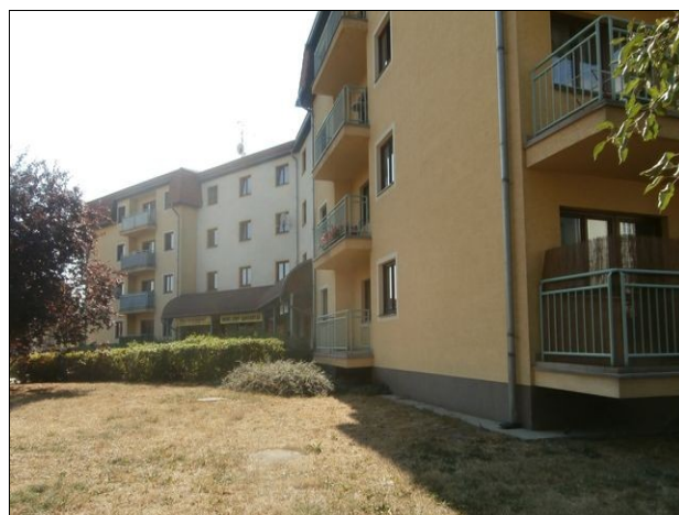
obr. /3/ Pohled na východní část objektu
