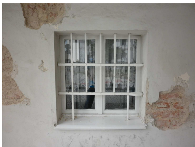
okno C1 exteriér
