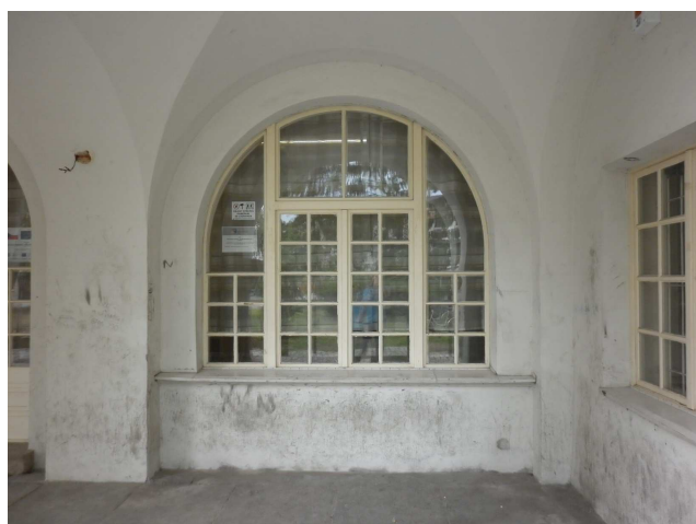
okno A1 exteriér
