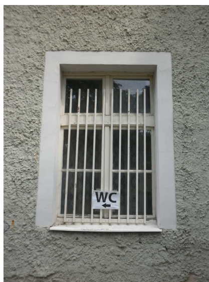
okno M1 exteriér
