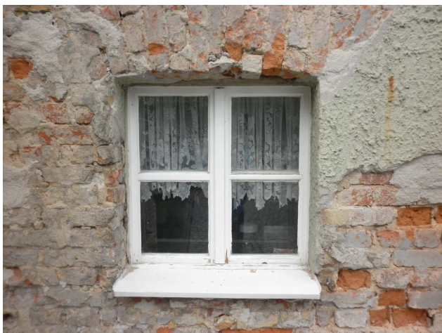
Okno C2 exteriér
