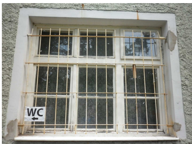
Okno N1 exteriér
