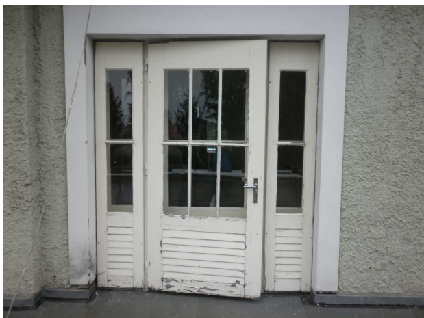
Dveře 2a exteriér
