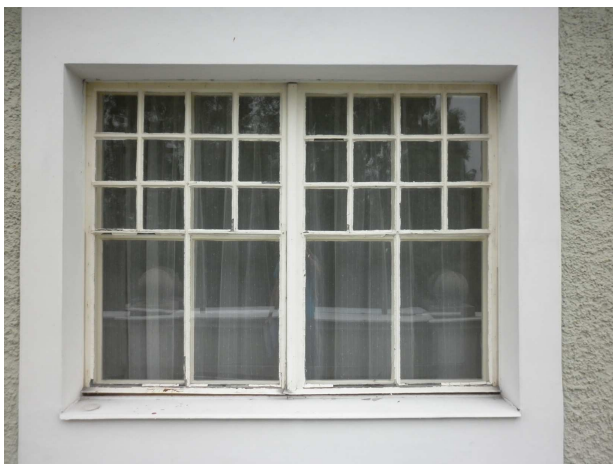
Okno D1 exteriér
