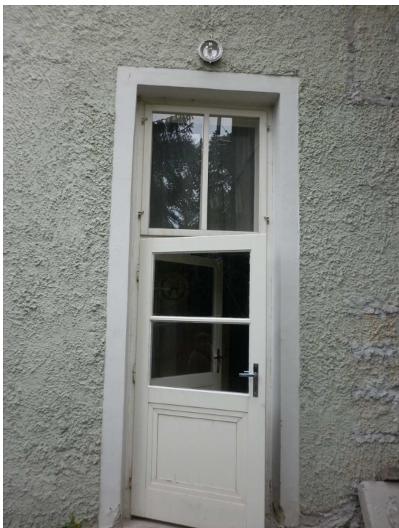
Dveře 7a exteriér
