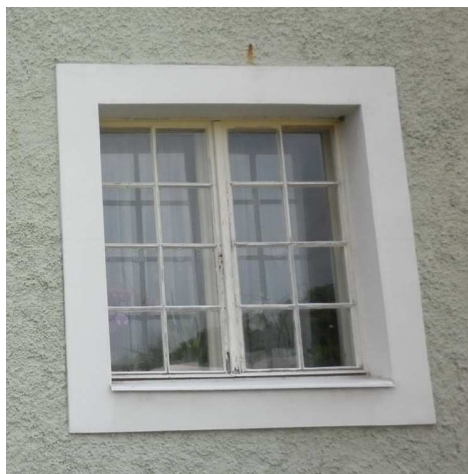
Okno H1 exteriér
