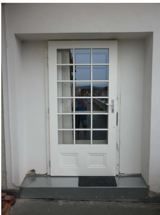
Dveře 6a exteriér
